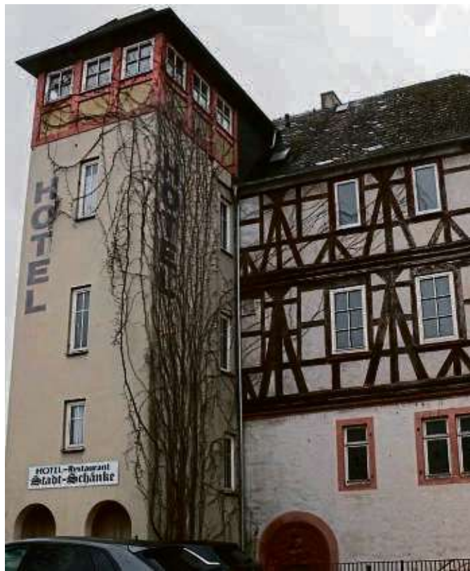
Die Baugenehmigung liegt vor: Nun kann die dringend nötige Sanierung des mittelalterlichen Fürstenhofes beginnen. Foto: PM
